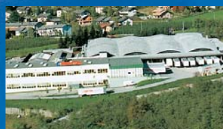
Stabilimento di Scurelle (I) finestre e vetrocamera
