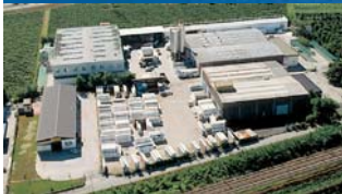
Stabilimento di Cortaccia (I) profilati e finestre
