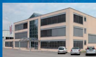
Stabilimento di Oppeano (I) finestre e vetrocamera
